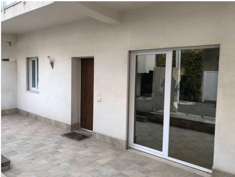
Vista immobile di cui al punto 1)
