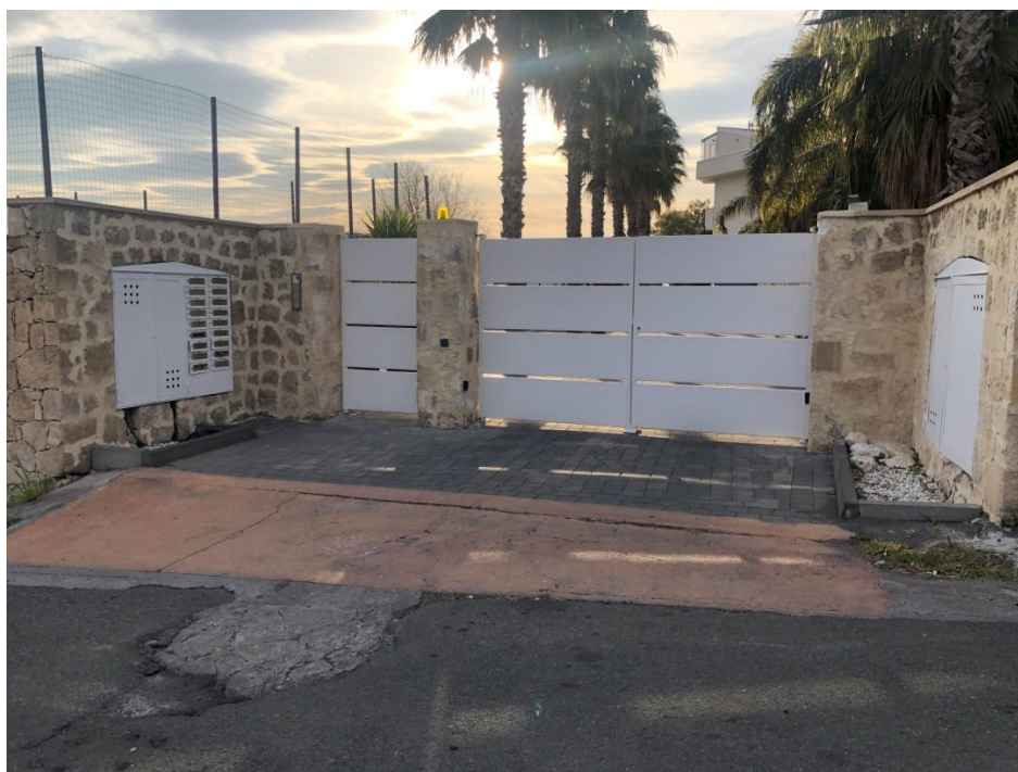
Vista aerea ed ingresso Condominio BorgoMediterraneo
