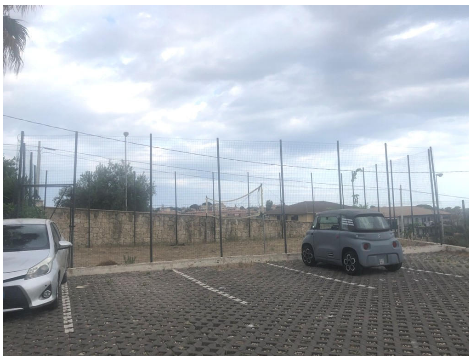
Vista immobile di cui al punto 3)
