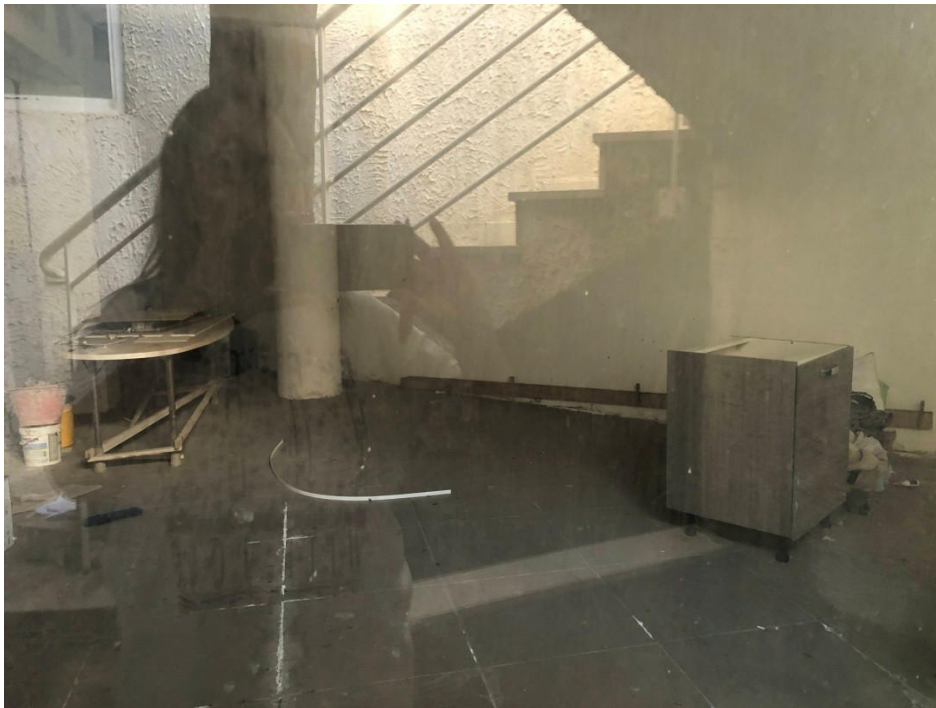
Vista immobile di cui al punto 13)
