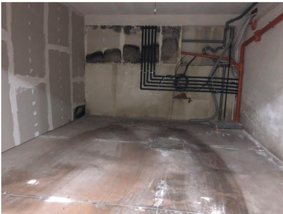
Vista immobile di cui al punto 10)
